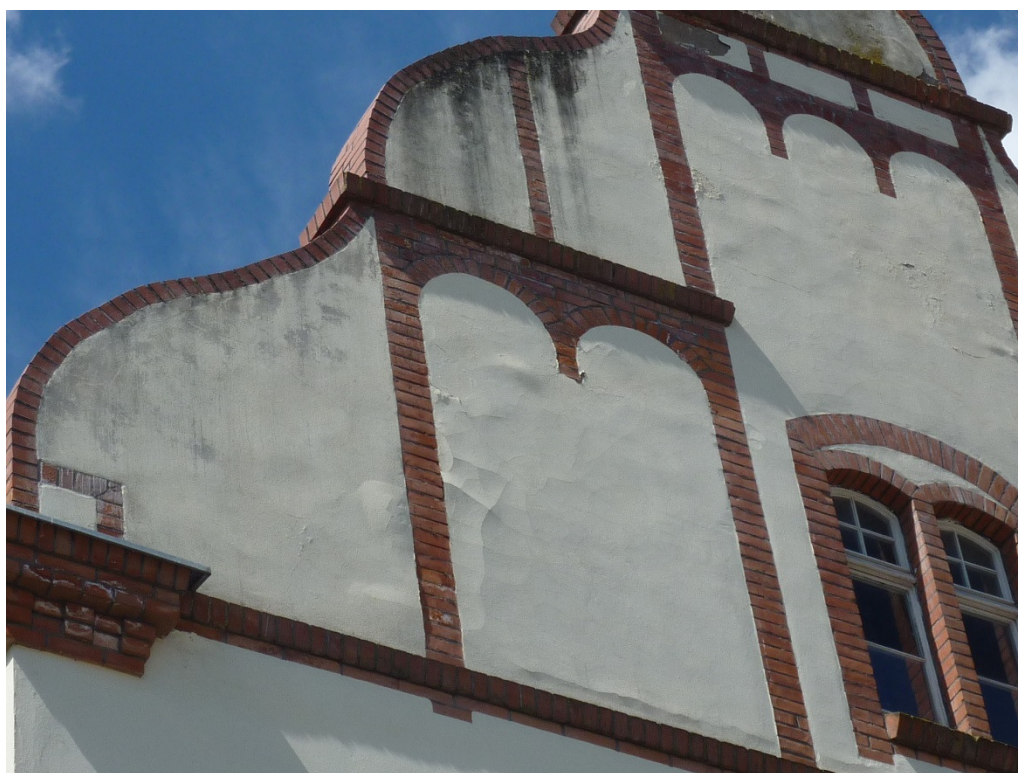
Fragment attyki ściany szczytowej (elewacja zachodnia)
