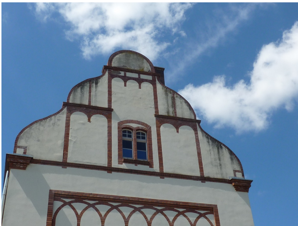
Attyka ściany szczytowej (elewacja zachodnia)
