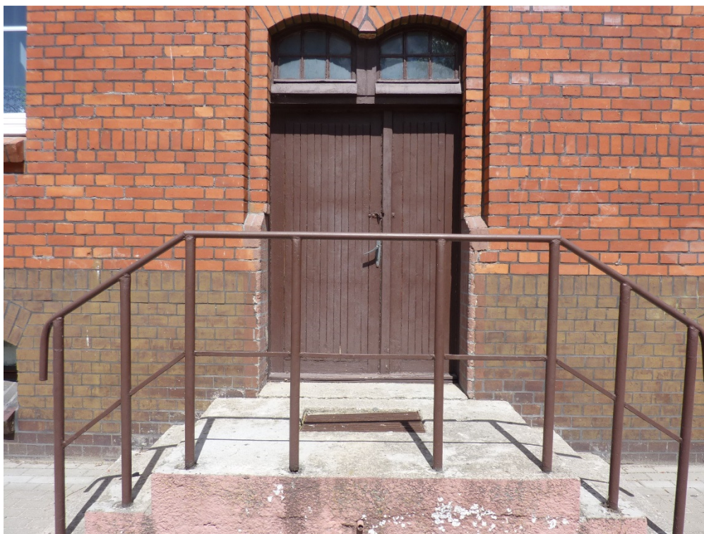
Wejście do budynku od strony południowej
