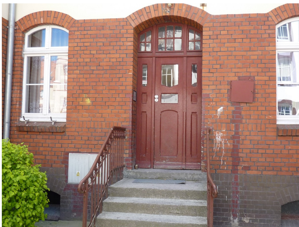
Wejście do budynku od strony północnej
